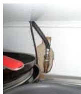
NIET conforme situatie
