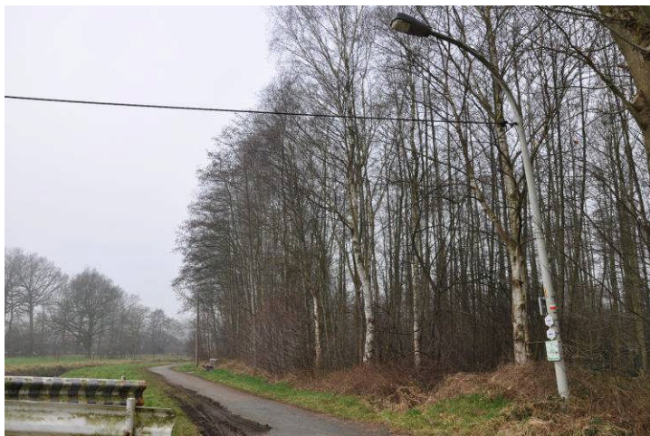
Foto: Elektrische bedrading 4c (Hofakker)
