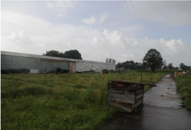
FOTO 7: buitenopslag en zicht op magazijn
